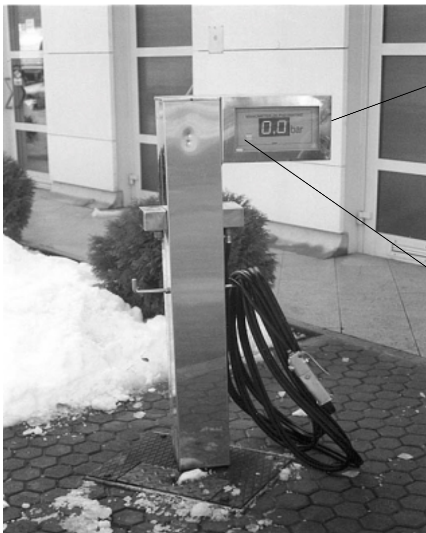
Slika 1: Fotografija uređaja (tlakomjera) za gume tip DMT 100 s prikazom mjesta za smještaj ovjernog žiga i mjesta za smještaj natpisa
